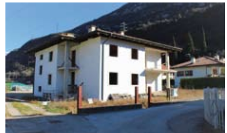
PADERGNONE casa singola al grezzo inserita su lotto di terreno di 550 mq, ampie cantine e garage, due piani abitativi, sottotetto, da finire! 120 mq per piano! Euro 275.000
